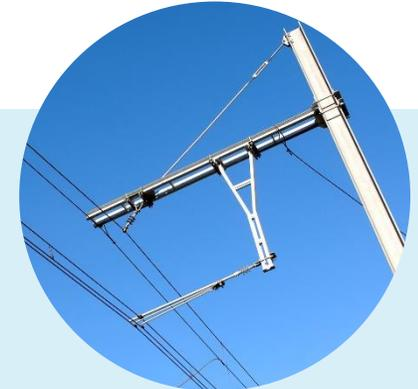
Les trains roulent grâce à l'électricité. Les fils électriques qui sont au-dessus des rails s'appellent les caténaires.
